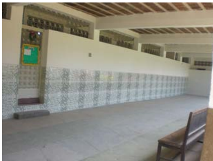
Die mit neuen Fliesen versehene Veranda
