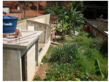
Bau der Freizeitanlage
